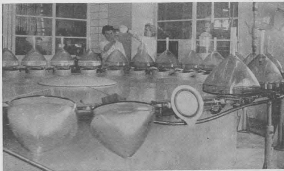
Obr. 105. Sedimentace zářivé látky v baňkách televizních obrazovek.
